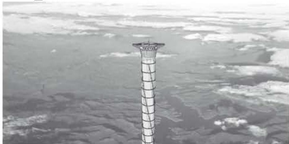
Tendría una estructura inflable de 20 km de altura, por cuyo interior circularía un elevador. Las naves podrían despegar verticalmente y alcanzar con mucho menor esfuerzo la zona llamada de órbita terrestre baja.
